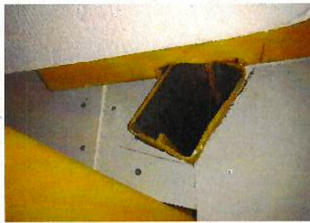
Fotografía N° 9 y 10: se aprecia corte en costanera por cruce de viga y soldadura al arco eléctrico con aspecto irregular.
