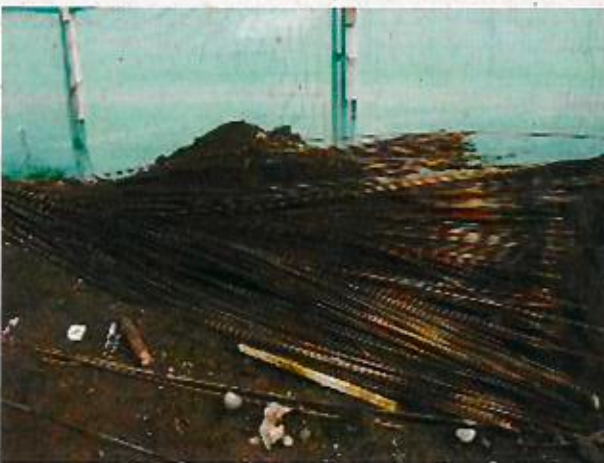
Fotografía N° 17: barras de acero acopiadas sin ninguna medida de protección contra la corrosión.
