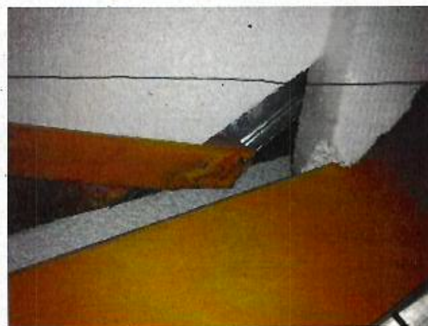
Fotografía N° 11: unión de costanera con viga de apoyo, con cortes y soldadura al arco eléctrico irregulares.
