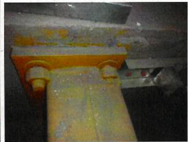
Fotografía N° 12: se observan varilla de anclaje soldada a la viga, además de presentar la tuerca y arandela visiblemente sin apriete suficiente.
