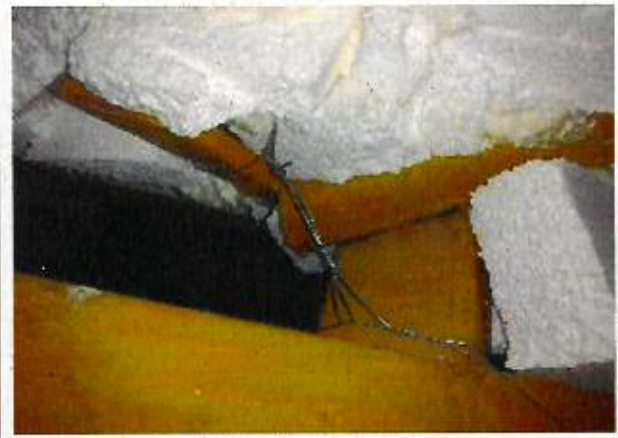
Fotografía N° 9 y 10: se aprecia corte en costanera por cruce de viga y soldadura al arco eléctrico con aspecto irregular.
