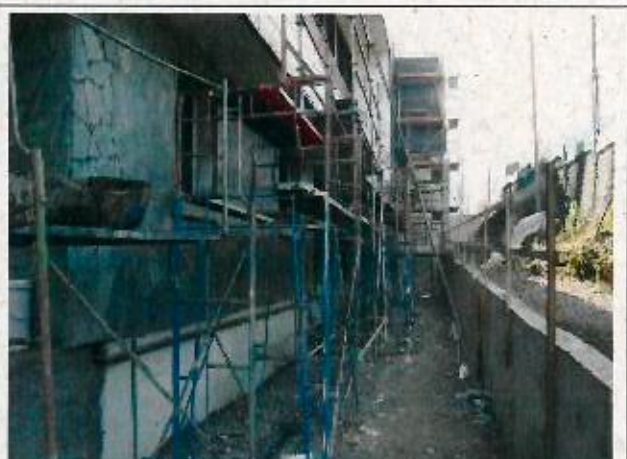
Fotografía N° 4: se observan andamios sin rodapiés ni barandillas.
