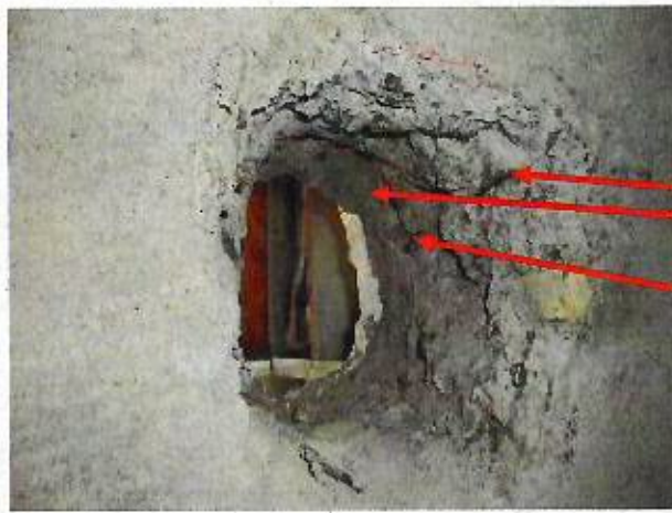
Fotografía N° 7 y 8: se puede observar la armadura cortada con esmeril angular, por picado posterior de muro, sin que esta acción conste que haya sido aprobada por el proyectista.
